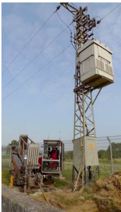
Der GRUNDODRILL neben der Freileitung, die erdverkabelt werden soll.
