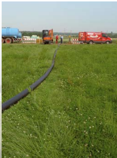
Der ausgelegte Rohrstrang.
